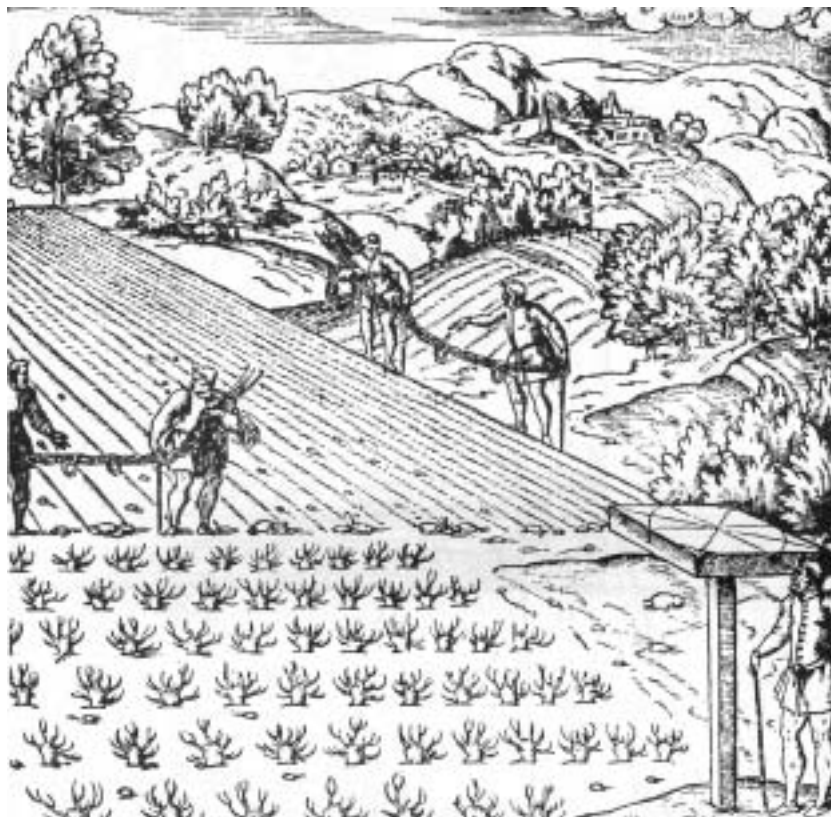
Die damaligen Feldmesser steckten die Grenzen und Grenzpunkte mit Hilfe von Ketten und Stäben ab. Die rechten Winkel wurden über eine Visiereinrichtung auf dem Feldtisch gefluchtet.
